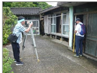
▼事前の測量等の様子（9/19~20に実施）
