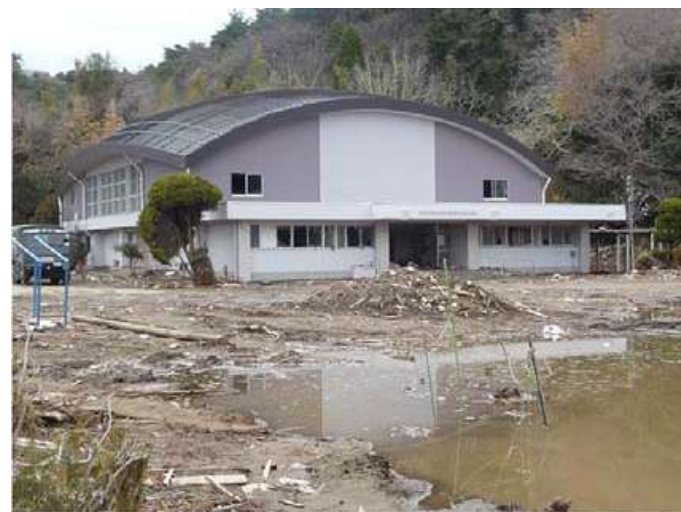
野蒜小学校体育館
