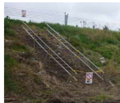
震災後設置された仮設階段
