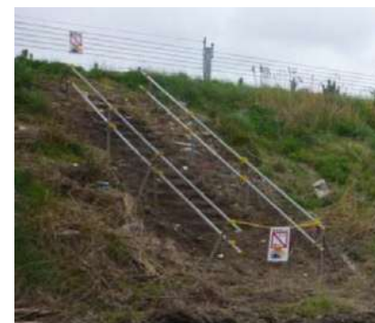
震災後設置された仮設階段
