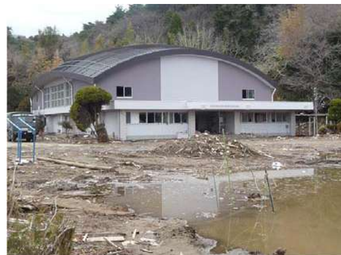
野蒜小学校体育館
