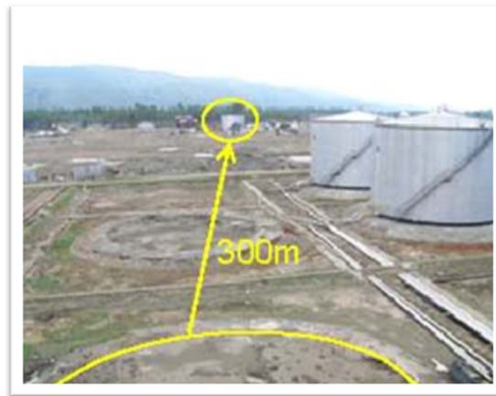
オイルタンクの津波漂流(インドネシア・バンダアチェ市)
