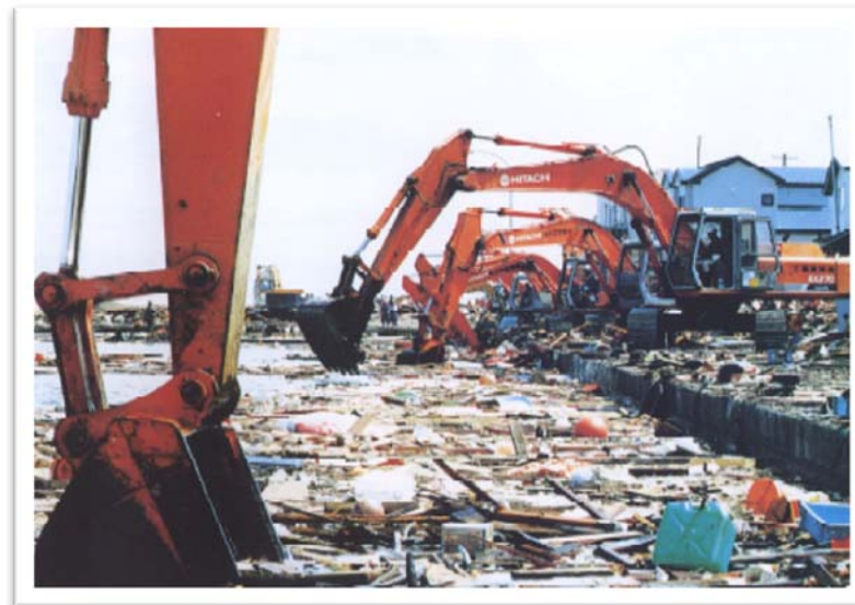
青苗港に流出した瓦礫の処理(北海道南西沖地震)
