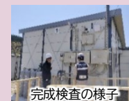
完成検査の様子
