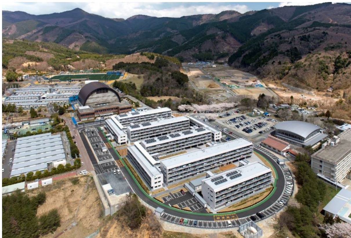
宮城県女川町 陸上競技場跡地地区 運動公園住宅(RC造・3, 4階・8棟)
