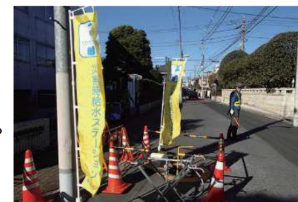
← 消火栓からの応急給水
