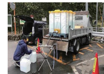
← 仮設水槽からの応急給水
