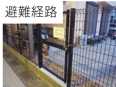
▲行き止まり解消のための扉設置
