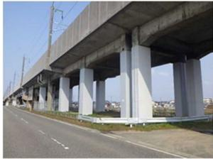
鋼板巻き耐震補強工法
