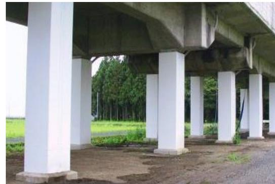
鋼板巻きによる高架橋の耐震補強
