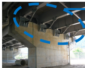
落橋防止構造
