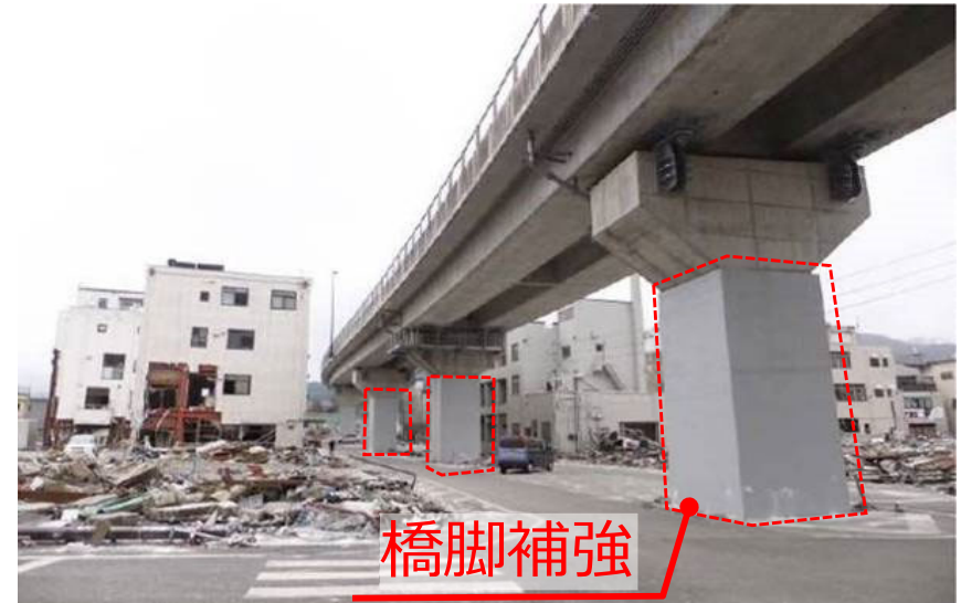
耐震補強の効果（国道45号釜石高架橋）
