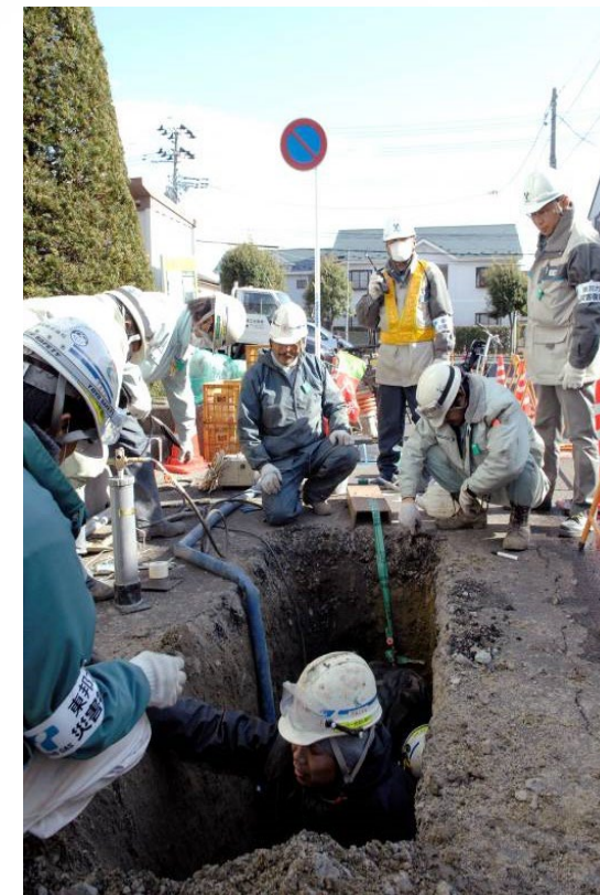
修繕作業の様子
