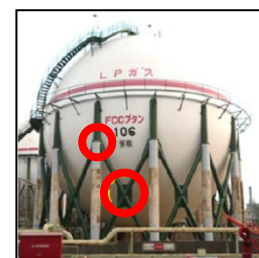
球形タンク筋交いの耐震補強
