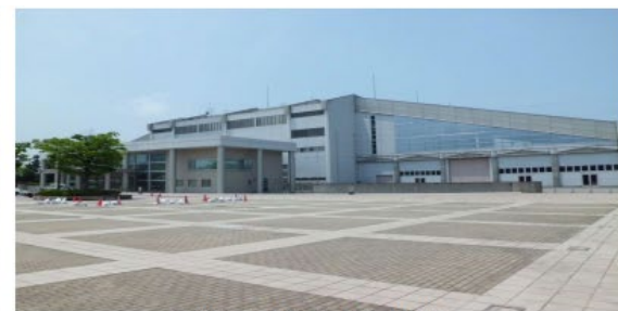
産業展示館4号館 外観
