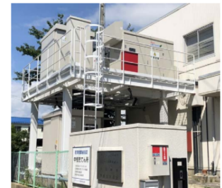
中核充填所における 自家発電設備の嵩上げ
