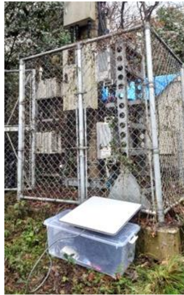
可搬型衛星アンテナ Starlink (KDDI)
