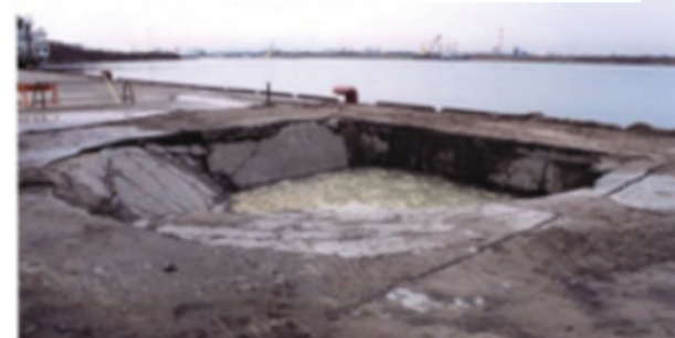
陥没した港湾施設のエプロン部分
