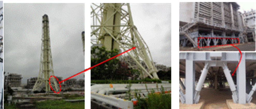
排熱回収ボイラ 「振動を抑制・吸収する」 支持架構の耐震補強
