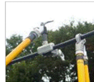
電線サイズ毎の アダプター取付
