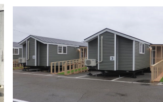
トレーラーハウス
