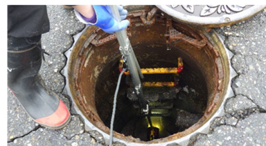
▲管口カメラによる管内調査
