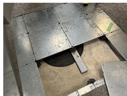
▲建物地下に設置された雨水貯留槽
