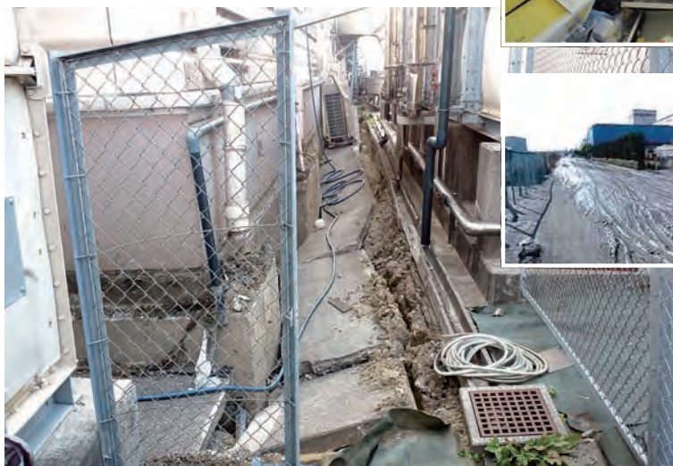
船橋市のB工場は液状化の影響で大きな損傷を受けた
