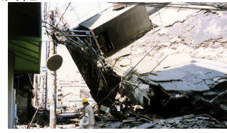
阪神・淡路大震災での被害
