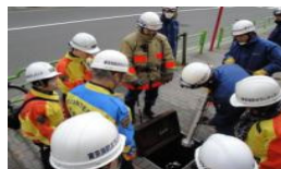
< スタンドパイプの訓練 >
