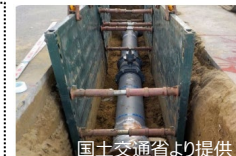
水道管路の耐震化
