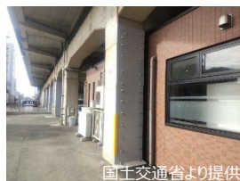
国土交通省より提供 鉄道施設（高架橋）の耐震補強
