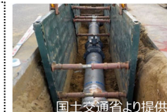
水道管路の耐震化
