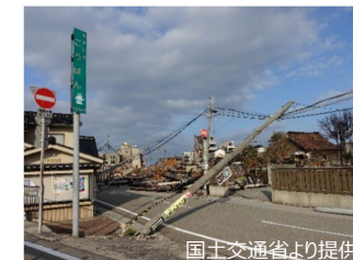
電柱の倒壊事例
