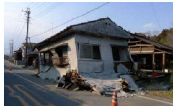
揺れによる被害
