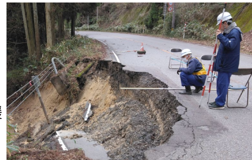
危険箇所での被災状況調査
