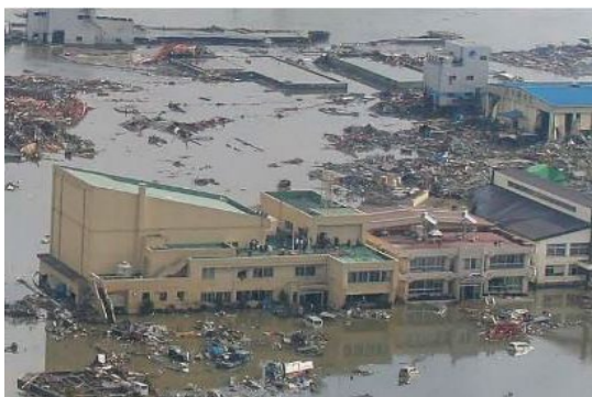
津波による被害
