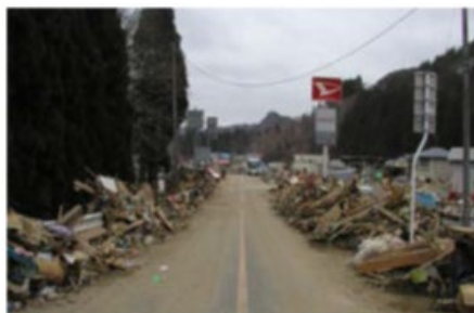
道路の啓開によるルートの確保
