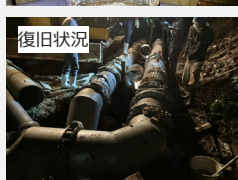
＜輪島市河井町＞仮設管抜け
