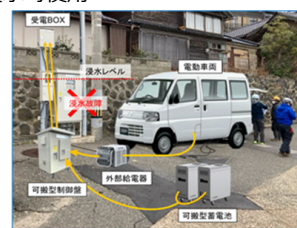
▲志賀町設置例(地震後に設置)
