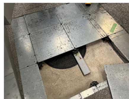
▲建物地下に設置された雨水貯留槽
