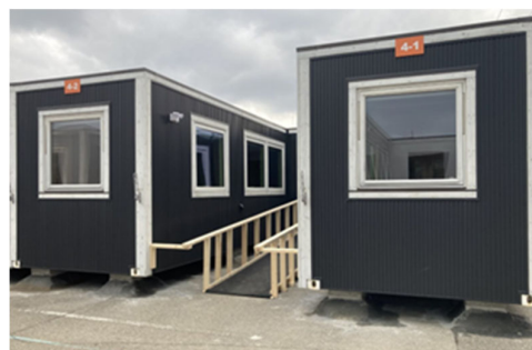
▲ムービングハウスの設置事例(石川県輪島市)
