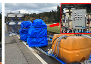
▲給水活動への活用(珠州市) 施設Ⅲ
