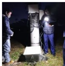
▲断絶した通信ケーブルの代替回線に利用し携帯電話の基地局を応急復旧
