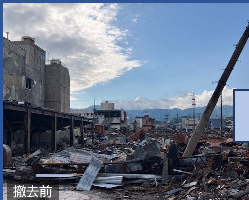
輪島朝市における解体・撤去工事
