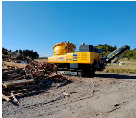
珠洲市ジャンボリー跡地仮置場： 移動式破碎機（稼働中）
