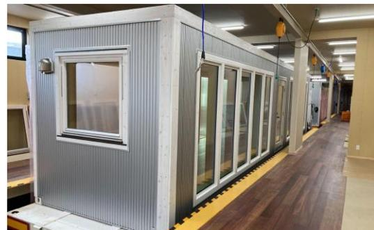
工場や展示場から出荷し、クレーンで吊り上げて基礎にセットします。
