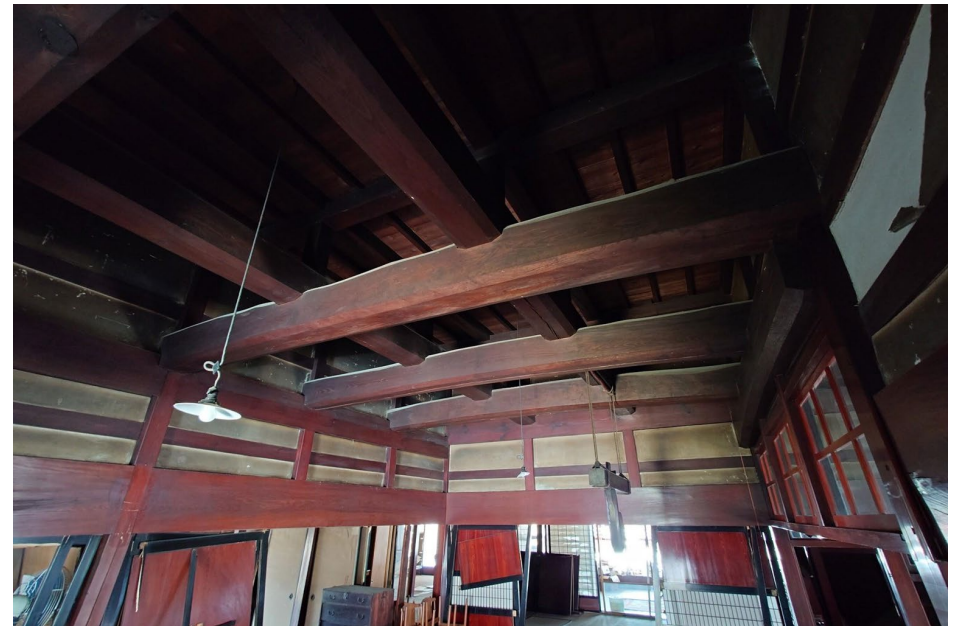
解体を待つ建物の内部
