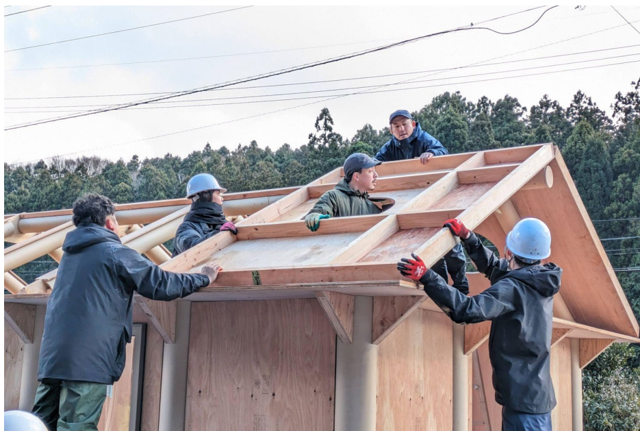
紙の仮設住宅の建設（珠洲市）
