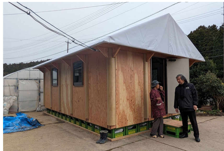
紙の仮設住宅（珠洲市）
