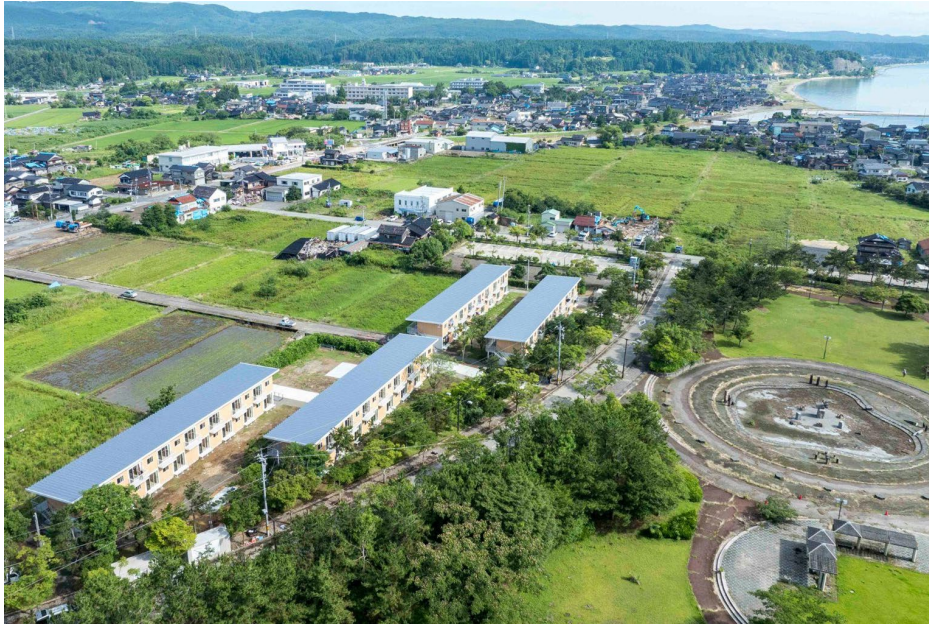
DLT恒久仮設木造住宅（珠洲市）
