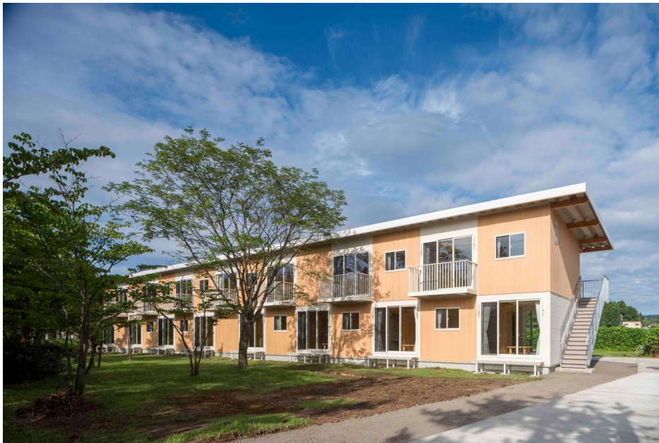
2024 DLT恒久仮設木造住宅（珠洲市）
