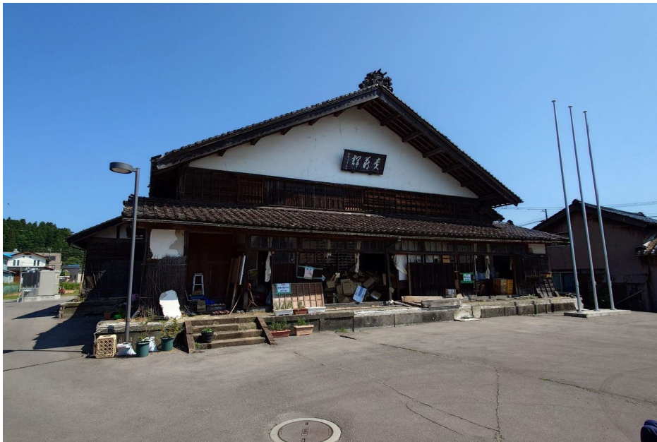
解体を待つ建物（珠洲市）
