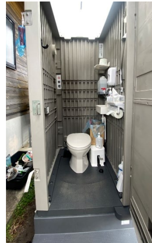
能登半島地震の事例 快適トイレ
