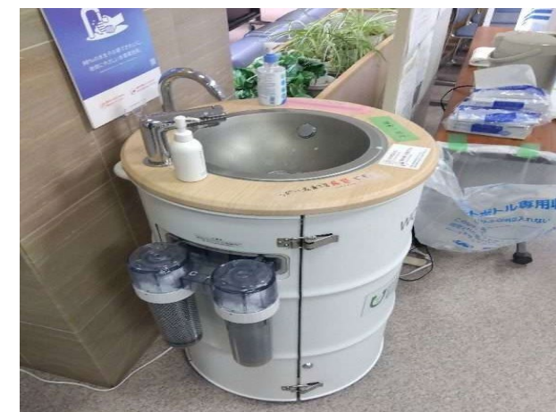
水循環型手洗いスタンド（志賀町）
