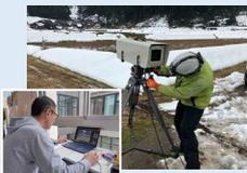
河道閉塞箇所への監視カメラの設置・市役所へのカメラ映像の提供（石川県輪島市）
