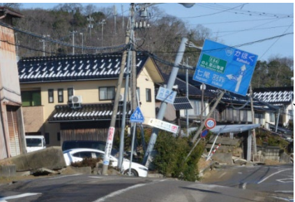
内灘町西荒屋地内（液状化）
