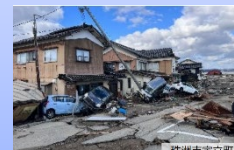
津波による浸水被害（珠洲市宝立町）
