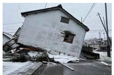
＜木造住宅の被害＞
