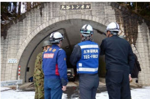
トンネル技術専門家(土木研究所・国総研) による現地調査(石川県珠洲市)
