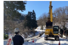
遠隔操縦式バックホウを安全性の確認できていない現場作業に使用し、2次災害を回避
