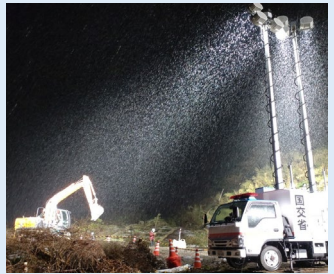
昼夜を徹した道路の緊急復旧 (石川県輪島市)
