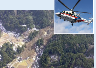
ヘリによる被災状況の把握 (石川県輪島市)
