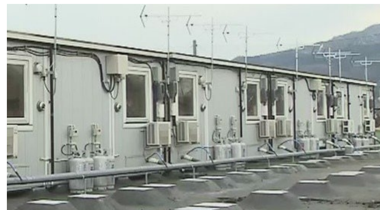
【仮設住宅へのLPガス設置】
