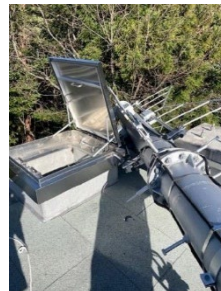
地域：石川県輪島市 支柱が折れ、送信アンテナが脱落
