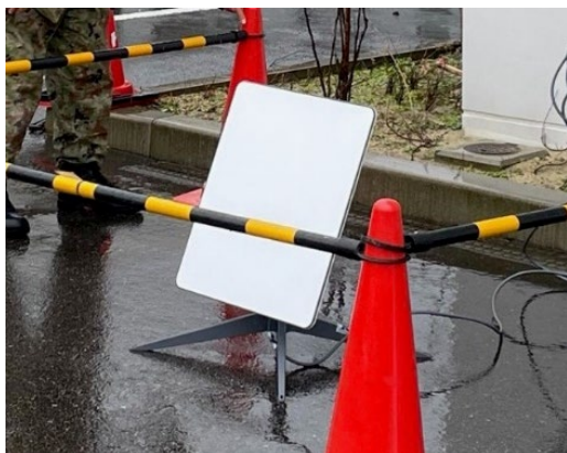
衛星インターネットサービスのアンテナ・機器の配備 (KDDI)
