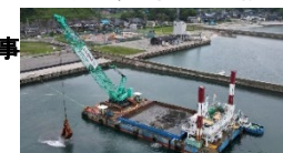
狼煙漁港における浚渫工事
