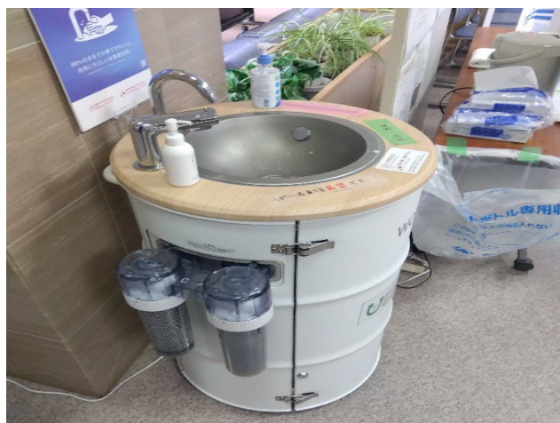
水循環型手洗いスタンド（志賀町）
