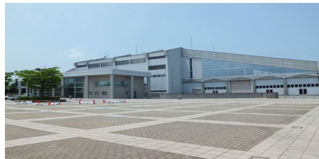
産業展示館4号館 外観
