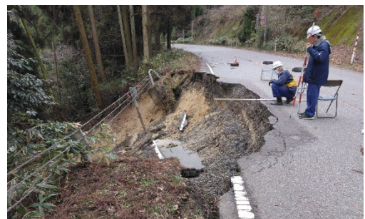
危険箇所での被災状況調査
