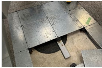
能登空港ビルの雨水利用施設
