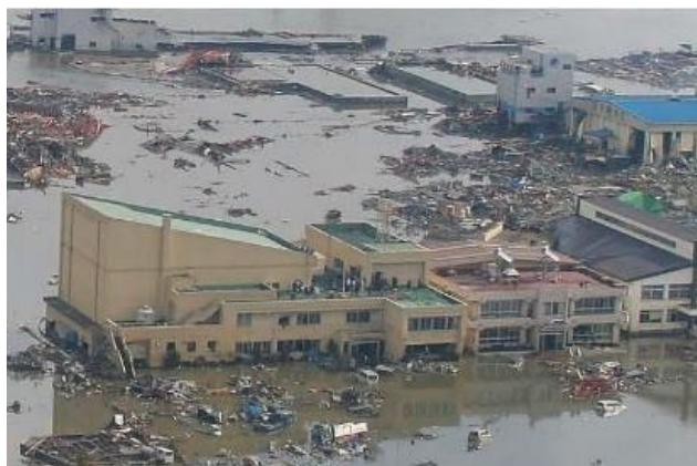
津波による被害
