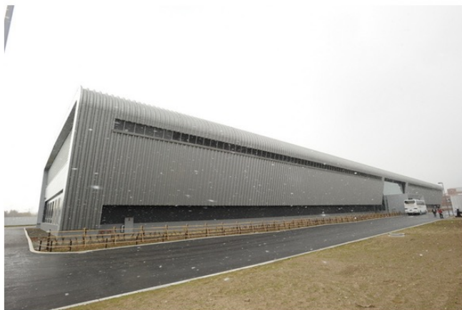
電力供給が回復したさくらインターネットの石狩データセンター
