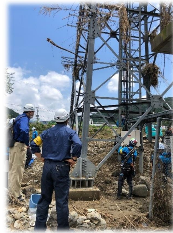
水没基地局設備 及び伝送路復旧
