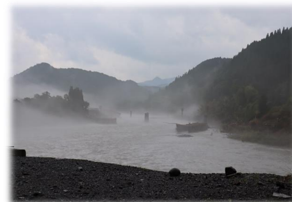
河川氾濫 (橋崩落)
