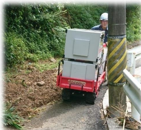
車両通行不可区域へ 発電機などの運搬
