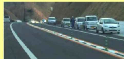
津波による被害がなかった三陸縦貫道
