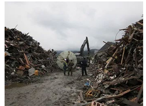
▼地震発生直後の道路状況イメージ （東北地方整備局ホームページより）
