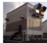
非常用自家発電設備のイメージ
