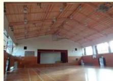
天井撤去後の屋根面に吹付け材を塗布し断熱性能等を確認
