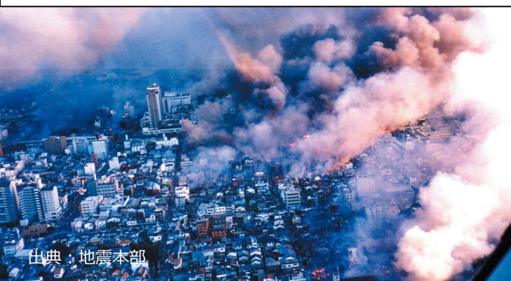
倒壊した建物、火気器具からの出火、通電火災などにより、次々と火災が発生し、広範囲で延焼する
