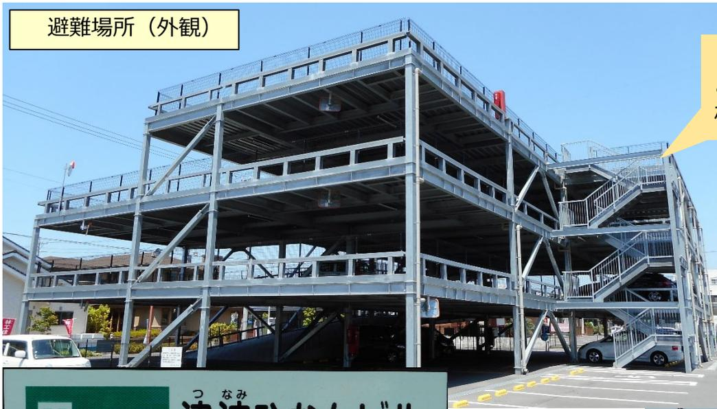
国土交通省告示に基づく構造計算により、鉄骨造の津波避難ビルとしての構造安全性を確認している。
