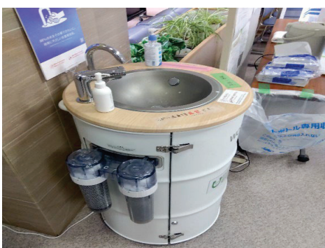
水循環型手洗いスタンド（志賀町）
