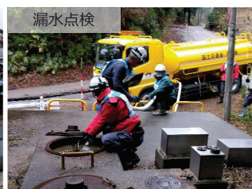
輪島市清土ポンプ場 配水管漏水調査
