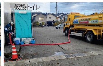
輪島市内 仮設トイレ約270基
