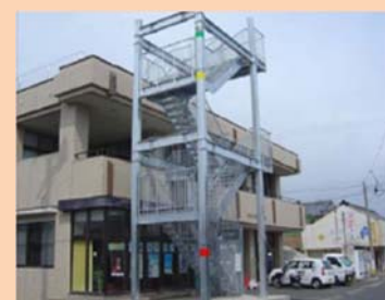
津波避難ビル外付部階段の設置
