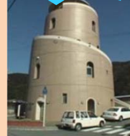
津波避難ビルの建設
