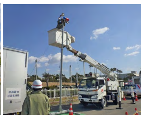
中部電力株式会社による仮送電訓練
