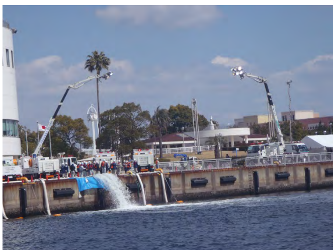
中部地整排水ポンプ車による浸水箇所の排水訓練
