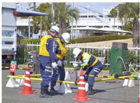
東邦ガス株式会社によるガス管応急復旧訓練
