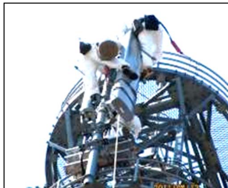
【4月13日】高性能アンテナを設置 (いわき市内の基地局)
