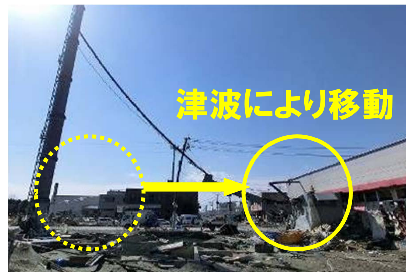
②基地局設備(宮城県 石巻緑町)
