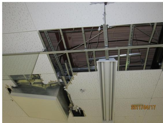
図表 天井落下及び損傷の状況
