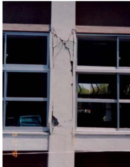
図 震災による構造躯体のひび割れ
