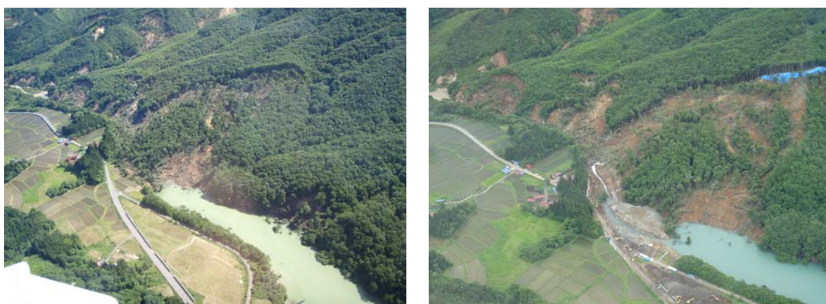
図 （対策工事の例）平成 20 年岩手・宮城内陸地震における磐井川（一関市 市野々原地区） 左：地震直後 右：対策工事
