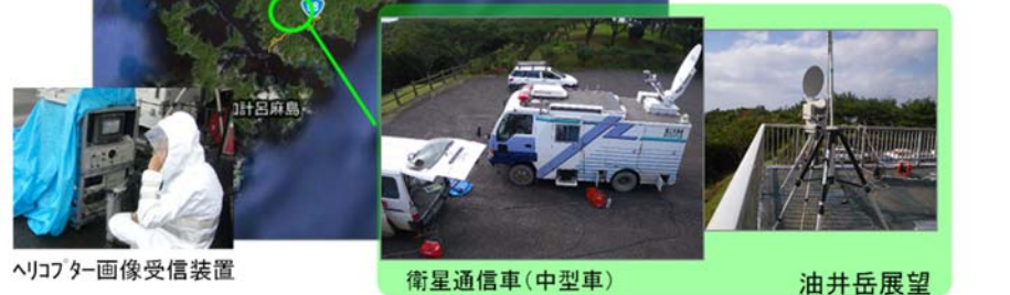
図 奄美災害防災通信機器設営状況
